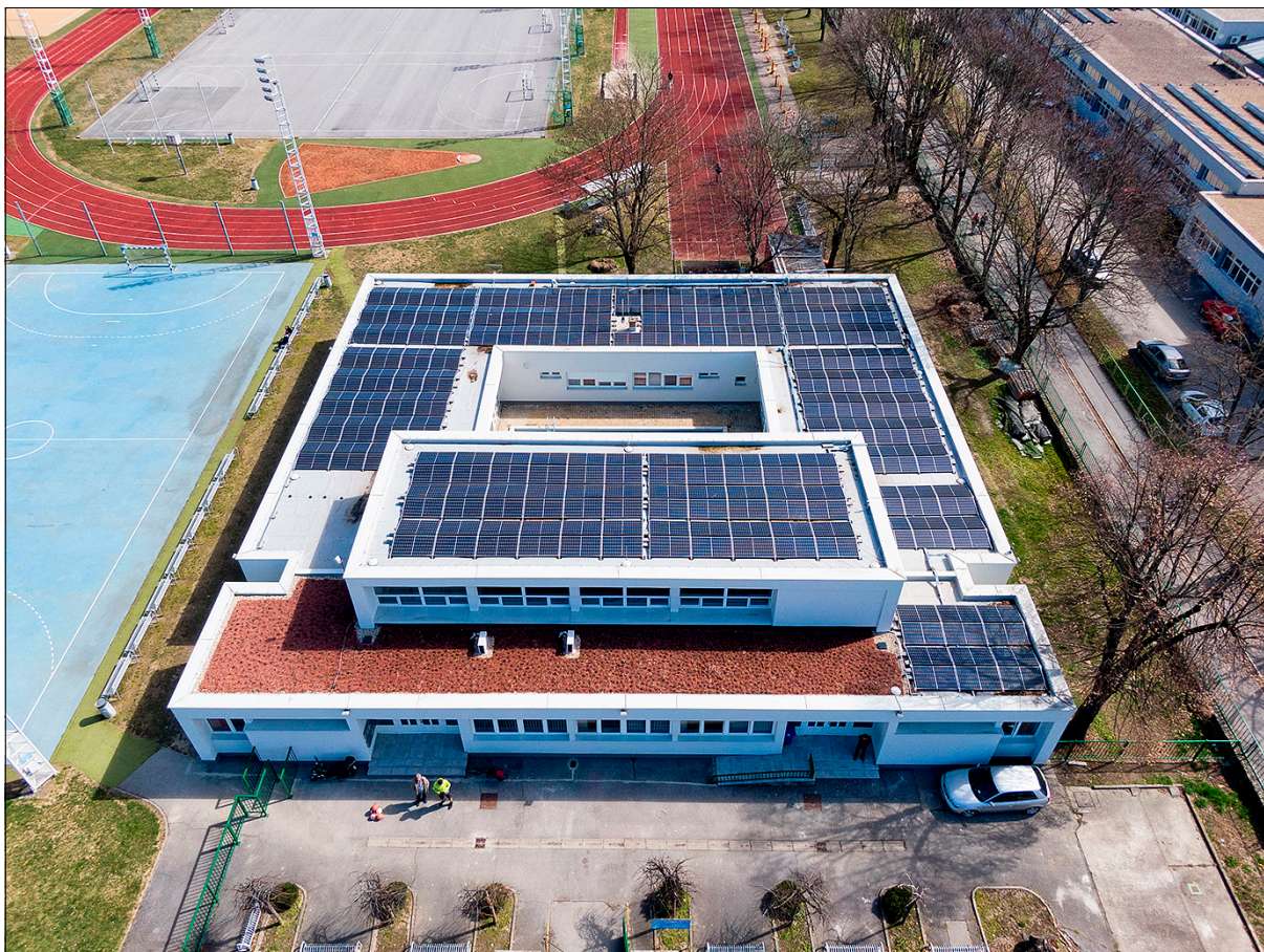
➦ Prilog 2. Instalirana solarna elektrana snage 93 kW na zgradi Srednjeskolskog igrališta u Osijeku u okviru GReENERGY projekta.
